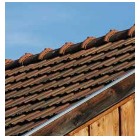
bontott tetőcserép és faburkolat
